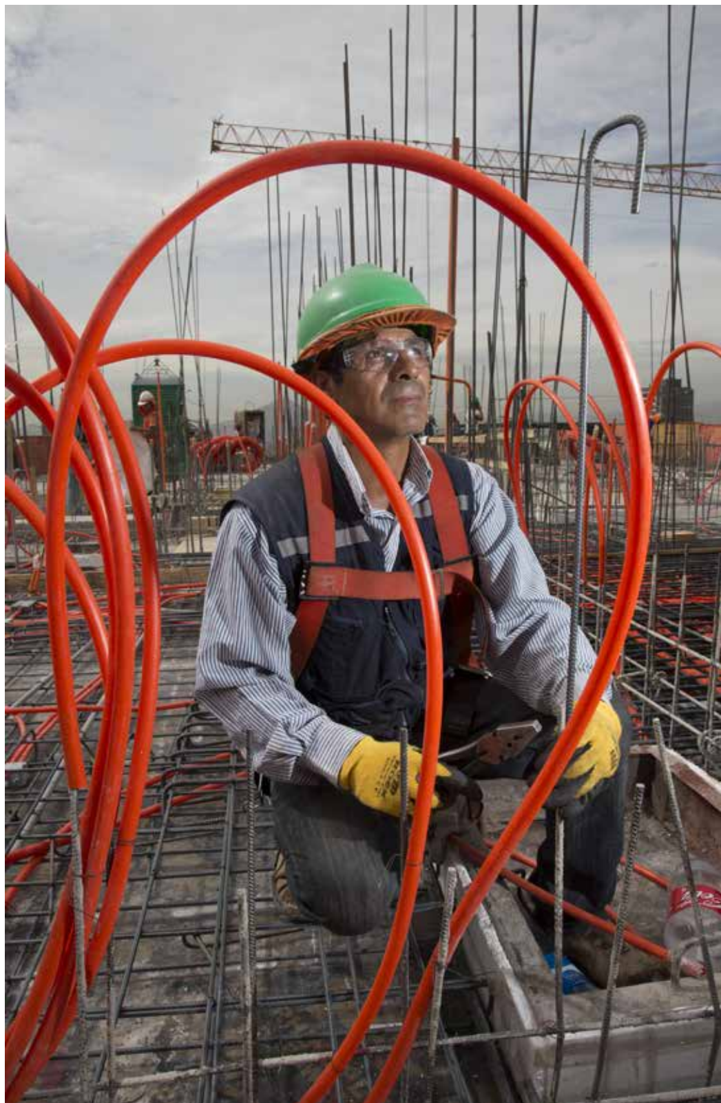
Construcción proyecto "Centro Alameda" / Estación Central, Santiago
