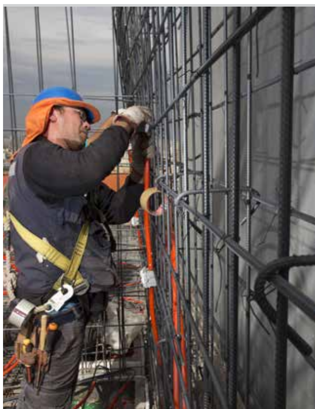
Construcción proyecto "Centro Alameda" / Estación Central, Santiago
