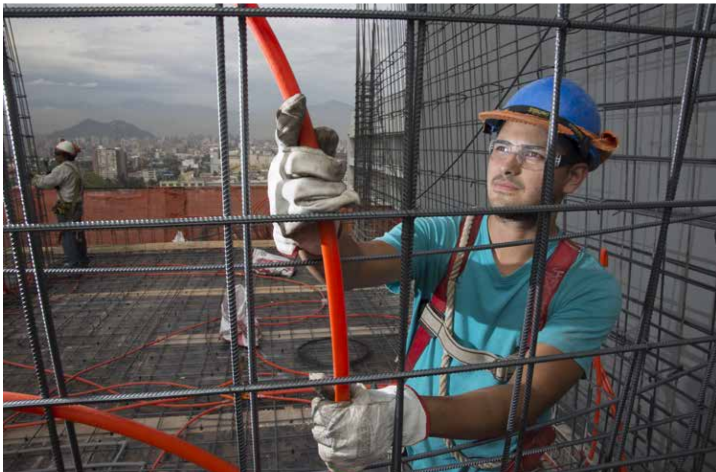
Construcción proyecto "Centro Alameda"/ Estación Central, Santiago
