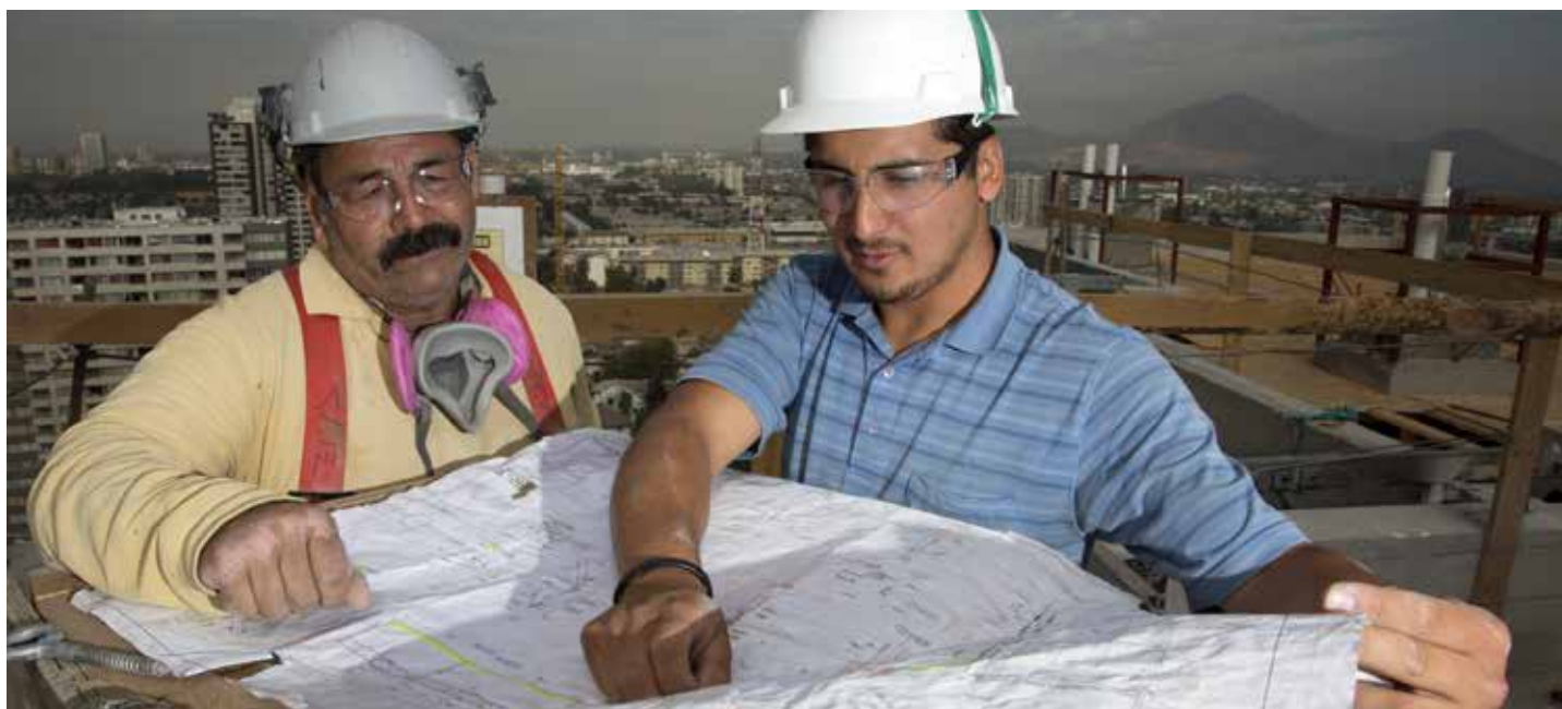
Construcción proyecto "Centro Alameda"/ Estación Central, Santiago
