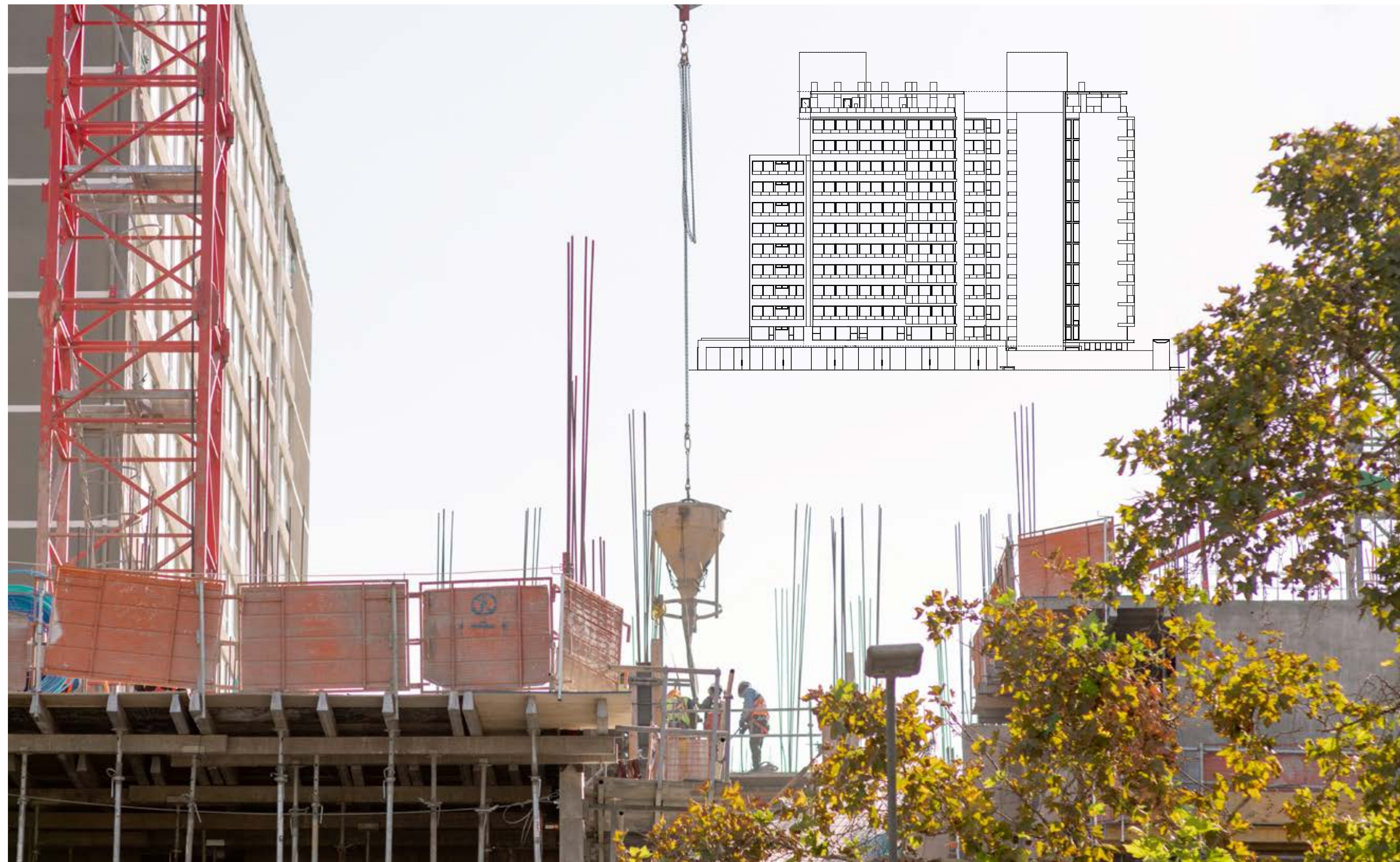
Edificio Santa Elvira - Santiago Centro - Chile
